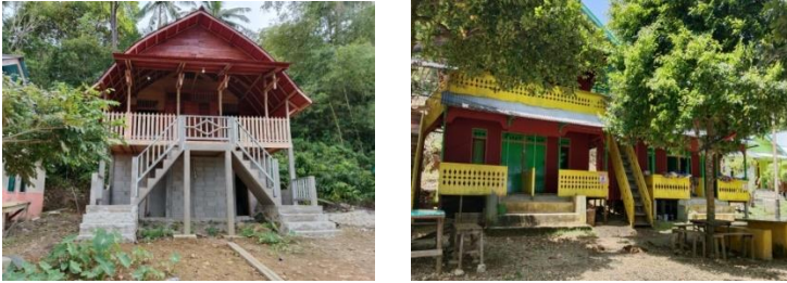
Figure 21: Penampakan Villa dan Homestay di Pulau Lemukutan
